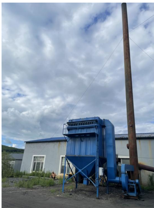
锅炉房除尘器+排气筒
