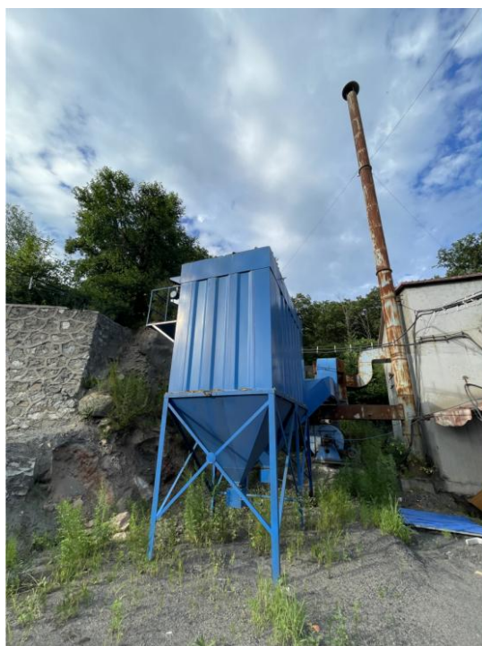
热风炉房除尘器+排气筒
