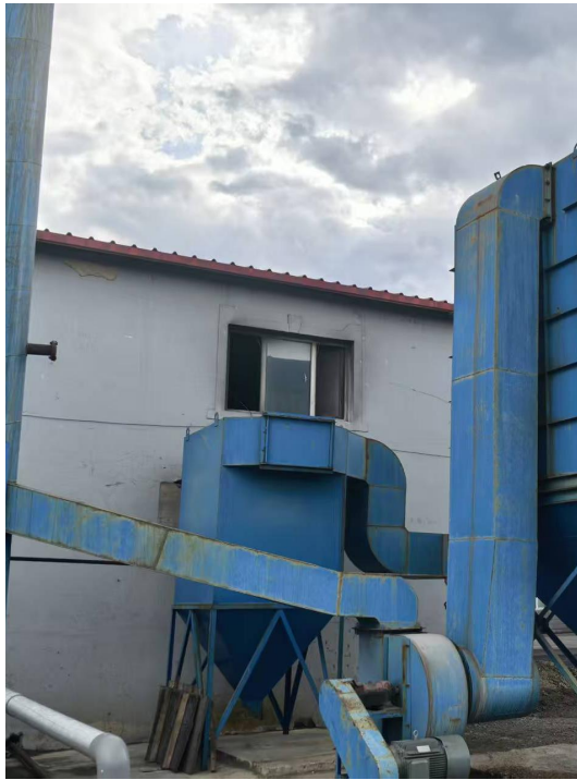
4t/h热水锅炉陶瓷多管除尘器
