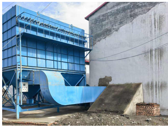
6t/h热风炉房布袋除尘器
