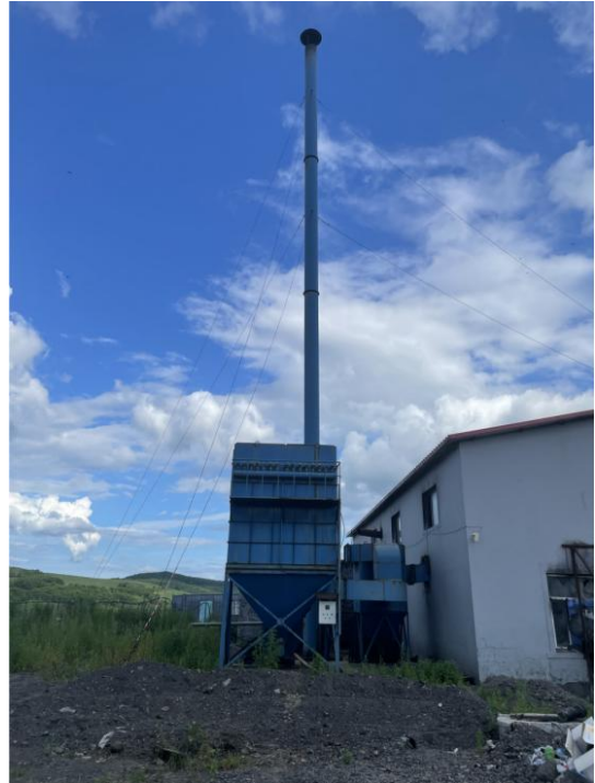
4t/h锅炉房除尘器+排气筒
