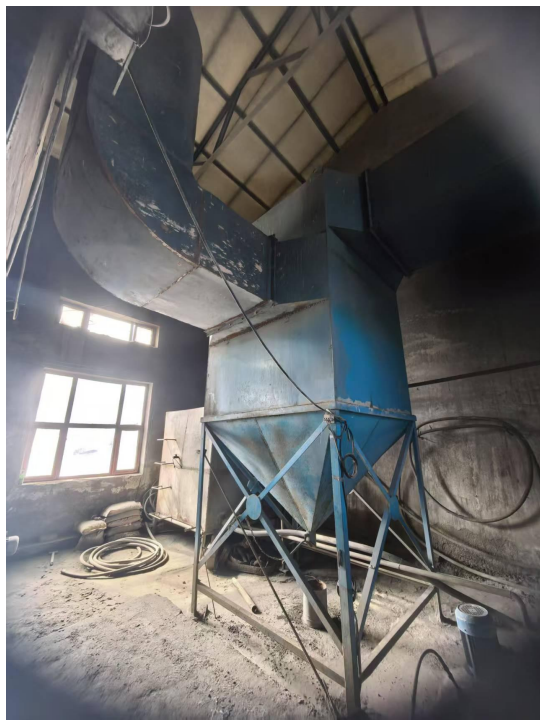
6t/h热风炉陶瓷多管除尘器
